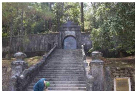
Fig.19. Buu Thanh Mon entrance (last gate)
