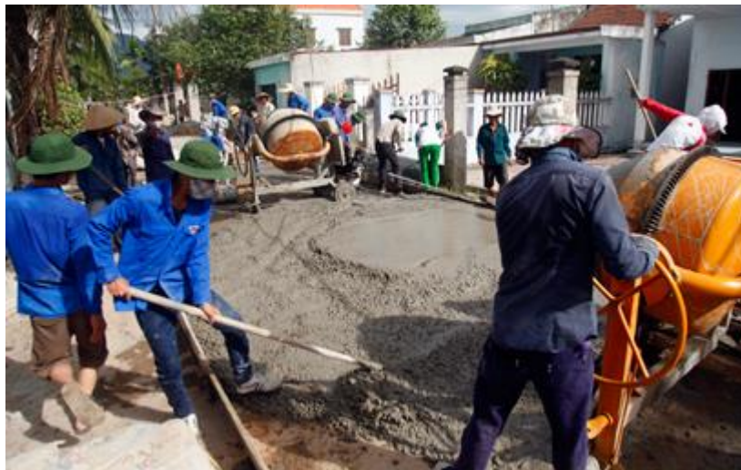
Đoàn tình nguyện Duy Tân đang xây dựng 200m đường bê tông
